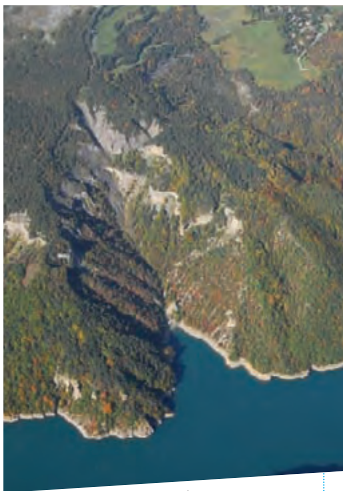
Vue aérienne de la Combe du Mas et du glissement de terrain de l'Harmalière © Photothèque IRMa/Sébastien Gominet
