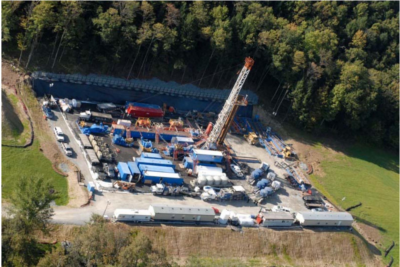
La phase de forage (~3-6 mois)
