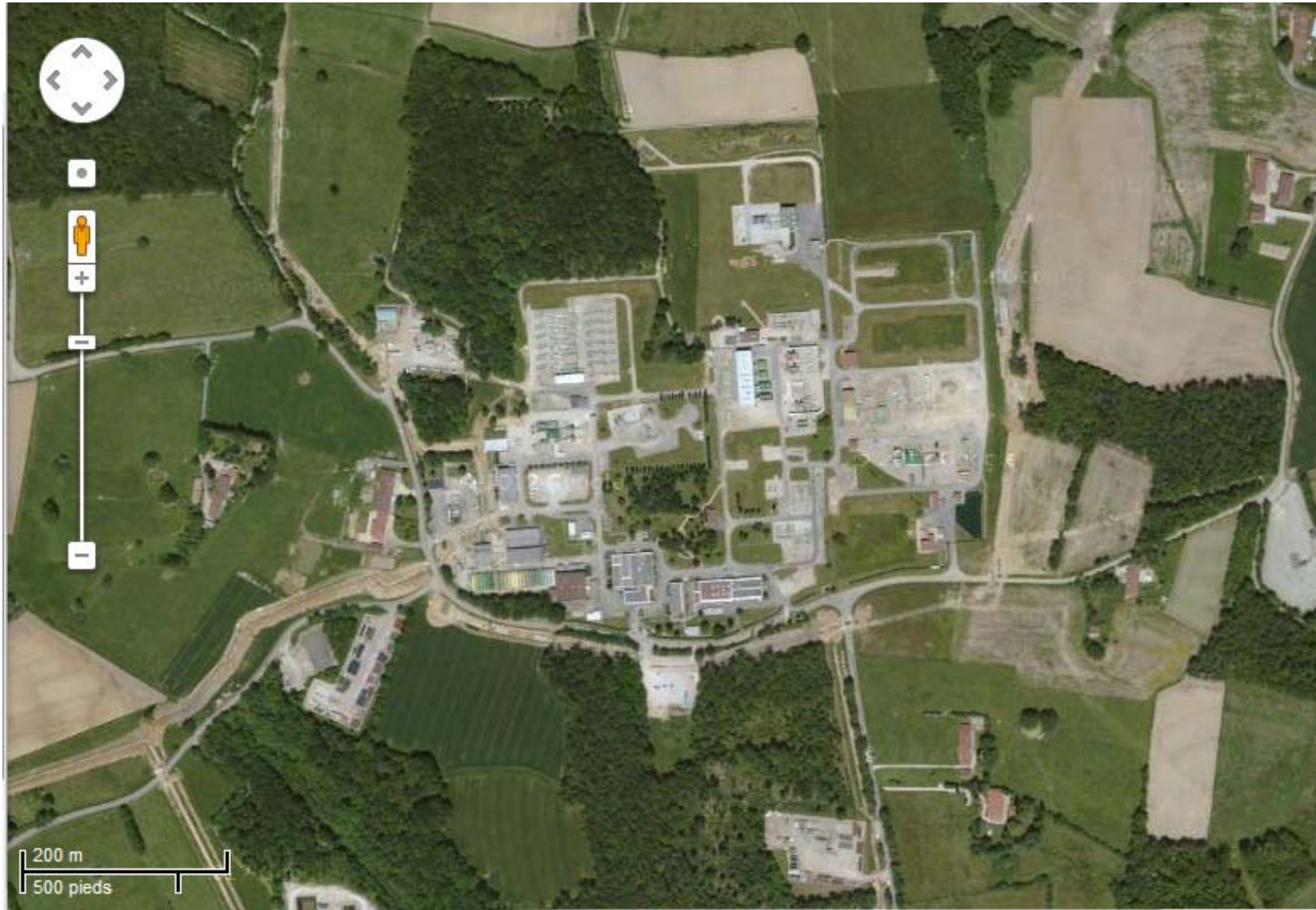
Site de stockage de gaz naturel à Etrez (01), Gournay-sous-Arondes (60), et aussi production à Lacq (64)
