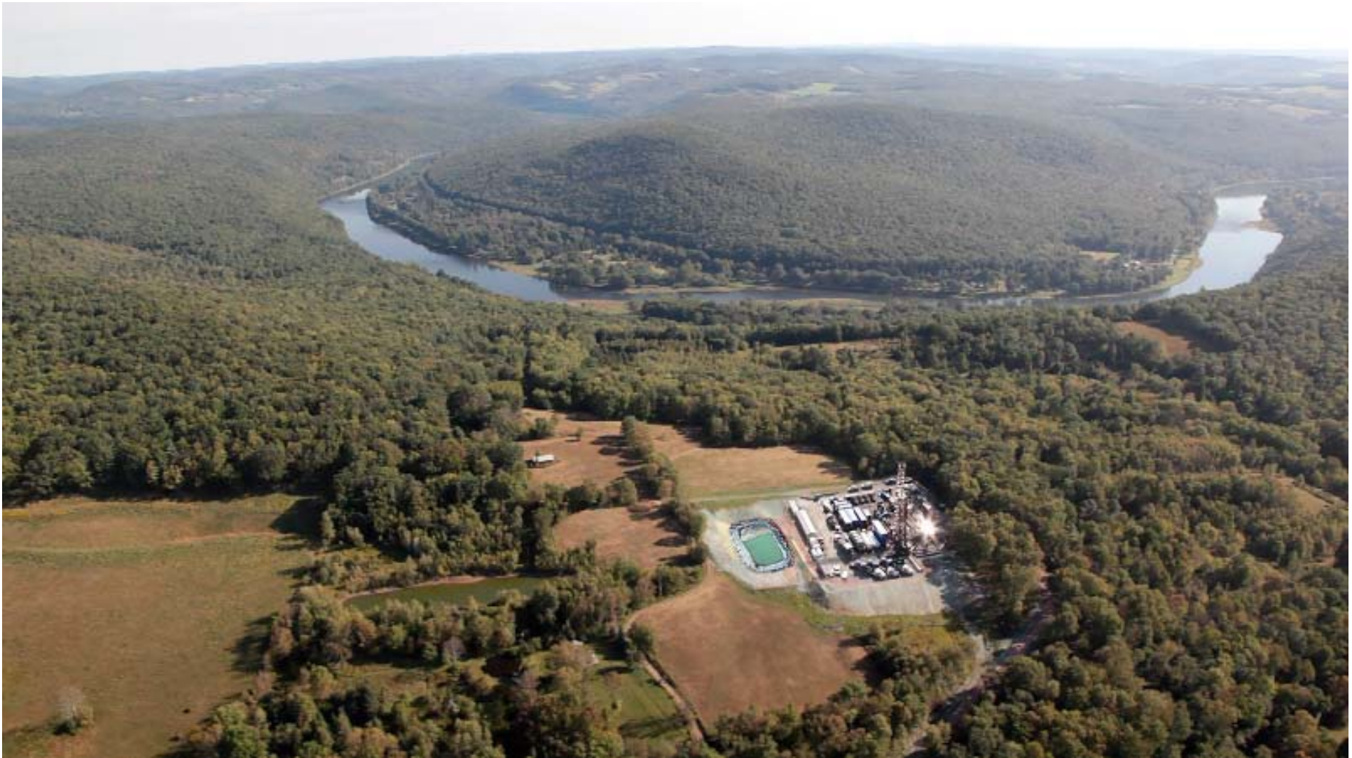
La phase de forage (~3-6 mois)
