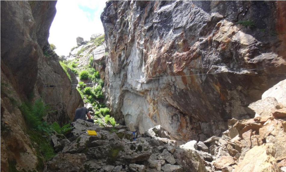
Fig. 4 : Faille de 8,849 m d'ouverture mesurée à l'aide d'un extensomètre à ruban. Le compartiment affaissé comporte un mur paravalanche datant du début du 20 ème siècle en position aujourd'hui étrange (à l'aval d'un fossé naturel de plusieurs mètres).
