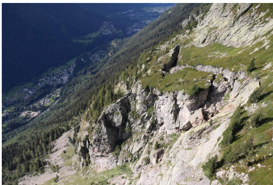
Fig. 2 : Photo aérienne prise à partir d'un hélicoptère à l'extrémité Nord-Est de la rupture dominant Argentière (Localisation sur la Fig. 1). On note une cicatrice amont avec mouvement de l'ordre de 8 à 10 m (voir Fig. 3) ainsi que des blocs déjà découpés et ayant partiellement glissés. Les trajectoires de ce type de blocs ont déjà été analysées (Tavernier, 2020).
